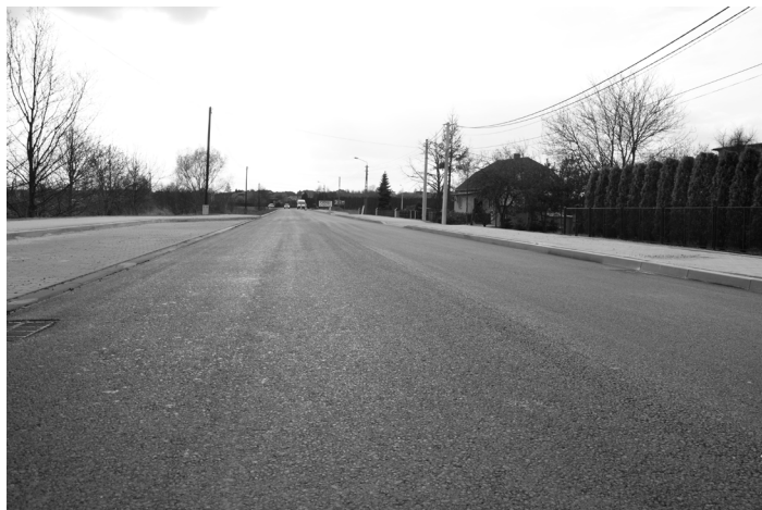
Nowa nawierzchnia jezdni na ulicy Czyżowickiej w Wodzisławiu Śl
