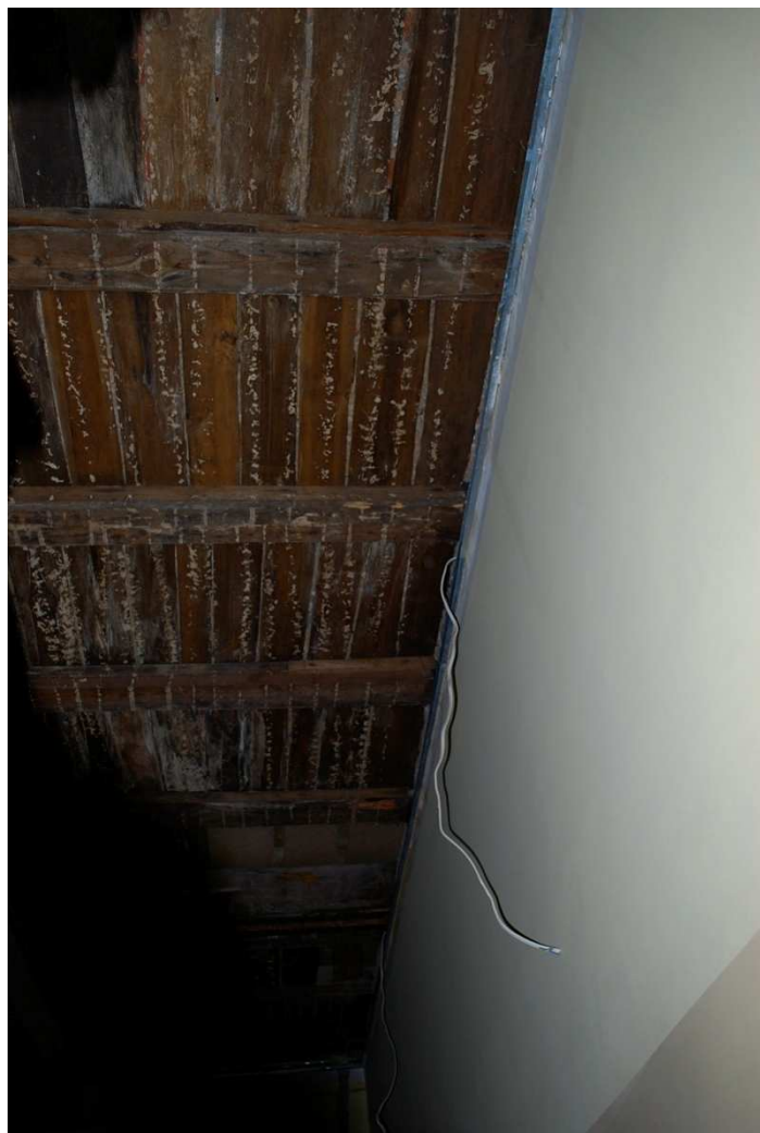
Fot. 01 Widok stropu po demontażu tynku na trzcinie i deskowaniu (po. 308)
