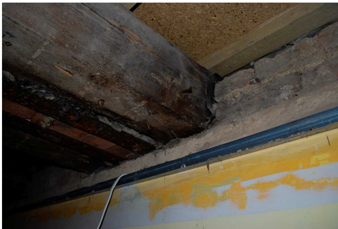
Fot. 03 Oparcie belki w gnieździe na papie, w miejscu oparcia widoczne przesmarowanie roztworem bitumicznym
