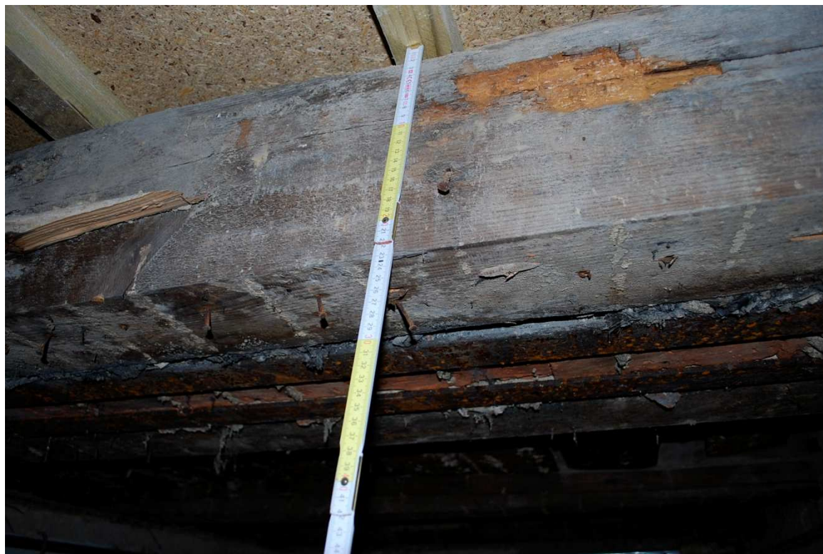
Fot. 04 Miejsce spróchnienie belki
