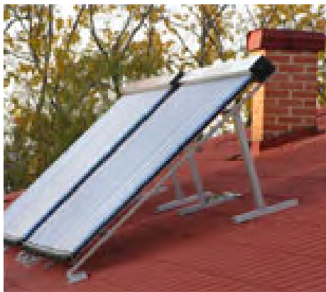
Rysunek 4.7 Kolektory słoneczne montowane na konstrukcjach wsporczych korygujących kąt nachylenia połaci dachu (fot. www.e-instalacje.pl )
