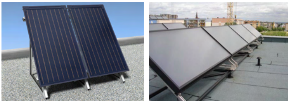
Rysunek 4.8 Przykłady konstrukcji wsporczych do montażu kolektorów na płaskich dachach lub gruncie (fot. Junkers i De Dietrich ).
