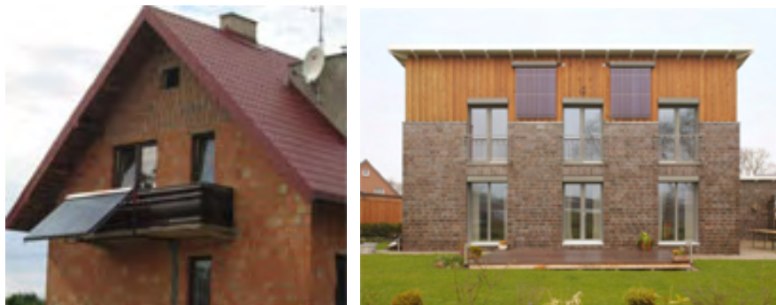
Rysunek 4.9 Przykłady montażu kolektorów balkonie i elewacji budynku (fot. www.e-instalacje.pl i Viessmann ).
